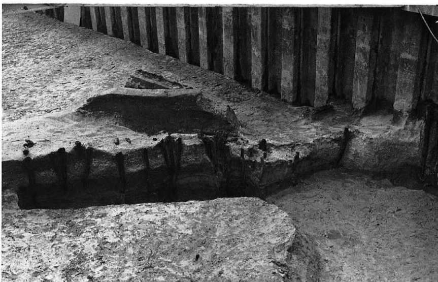
根入れ状況 (←北東)
