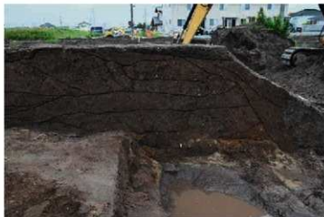
盛土断面 東西ライン T-1 付近 堀からの立ち上がり (北から)
