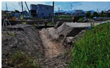
W-3 調査状況 (東から)
