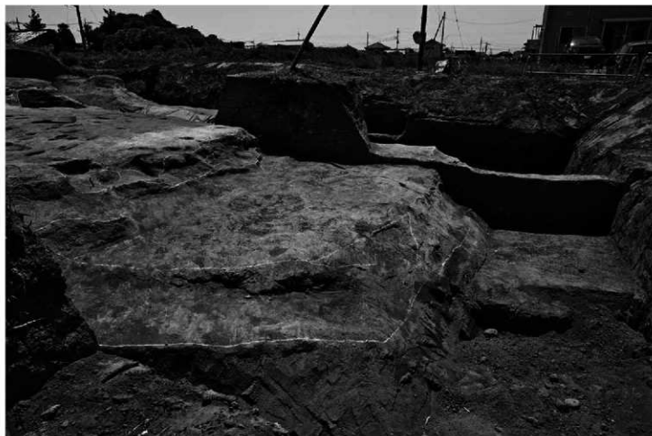
X-1とW-1張り出し部(北から)
