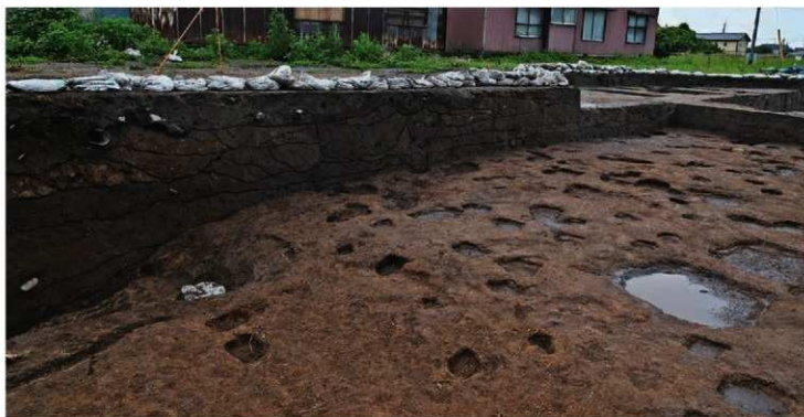
盛土断面 南北ライン 北半 (北西から)
