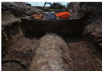
W-1 中央トレンチ 調査状況 (北から)
