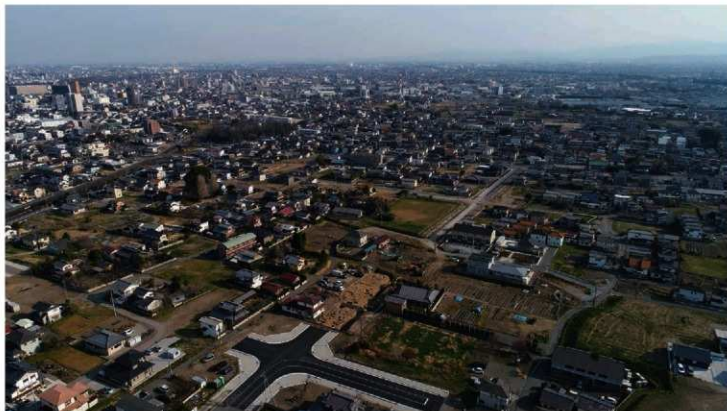
北西上空から見た元総社蒼海遺跡群 (148) 調査区
