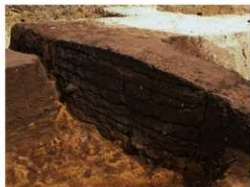
◀ 掘込地業(布地業)の断面にみえる版築のようす (元総社遺跡発掘調査報告書 146)
