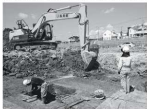
写真1 機械掘削
