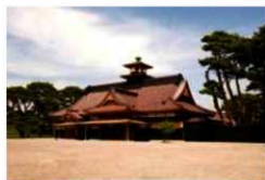
復元された函館奉行所庁舎
