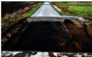
町道敷地内で検出された堀
