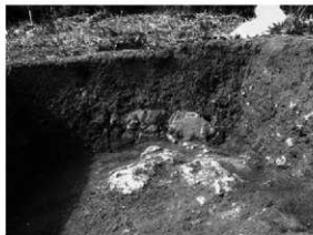
写真45 試掘坑2完掘状況西壁
