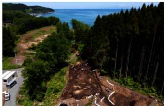
電電公社合宿舎遺跡 作業状況
