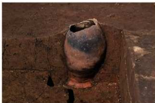
SI474A カマド西袖 芯材 (C-189) 埋設状況 (南から)
