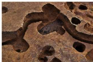
SI440 張り出し部 (北西から)
