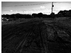
本調査終了風景 (北から)
