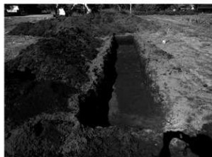
4トレンチ (南から)
