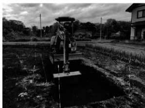
瀬戸大畑遺跡 (第5地点) 本調査重機掘削状況
