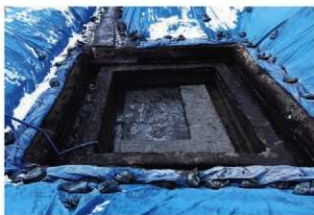
A区SR2河川跡掘削途中(東から)
