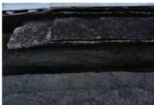
C区西側南壁断面②（北から）
