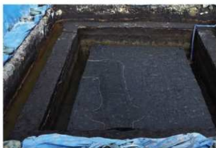
A区10a層上面 水田跡確認状況 (西から)
