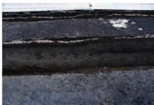
C区西側南壁断面③（北から）
