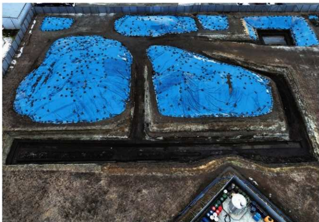
B区 調査完了状況 (南から)
