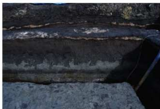
A区東壁断面②（西から）
