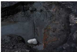
C区西側SD1溝跡 掘削途中（東から）
