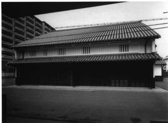
1. 旧岡田家酒蔵店舗南面（解体修理後）
