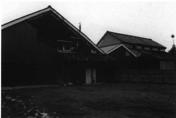
2. 旧岡田家酒蔵店舗・釜屋・酒蔵東面（解体修理前）
