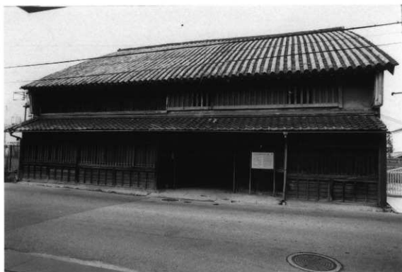
2. 旧岡田家酒蔵店舗南面（解体修理前）
