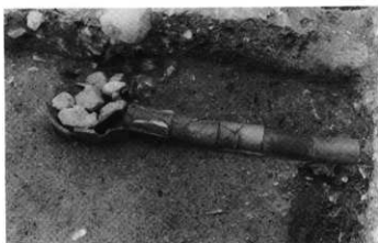
3. 丸瓦組み暗渠 (北から)
