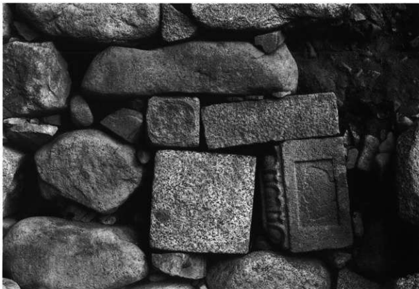
第16次調査 石造品の石垣転用状況(2)
