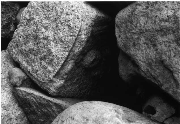
第16次調査 石造品の石垣転用状況(1)
