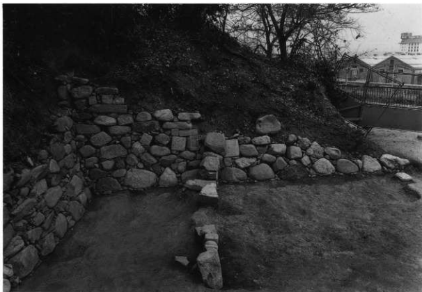
第16次調査 南面石垣
