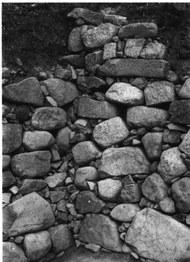
第16次調査 南面石垣と東面 石垣の接合部
