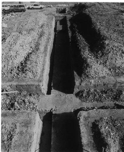
a 東西トレンチ (北) (西より)
