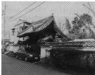
写真1. 遍照院の現況
