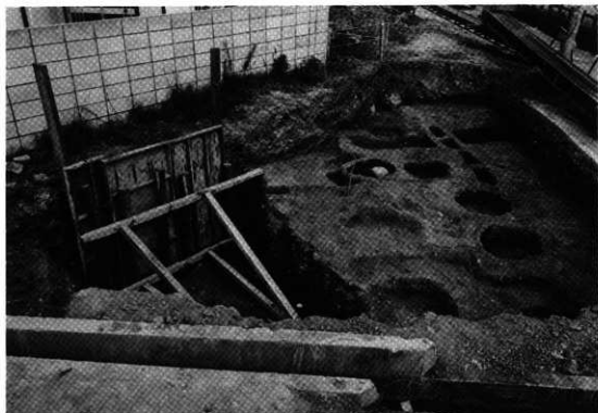
第3トレンチ(南から)
