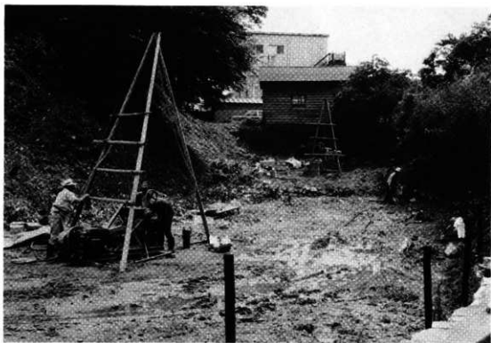
ボーリング調査の状況
