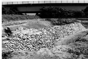
保存された近世の堤防（上岡北遺跡）
