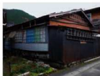
図10 平屋建鉄板葺の主屋
