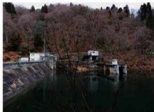
図6 三滝ダム北側の県有地
