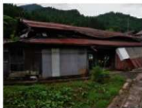
図9 平屋建鉄板葺の主屋
