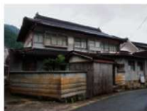
図13 2階建瓦葺の主屋
