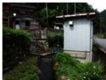
図14 イトバ (No.1) と消雪用ポンプ場
