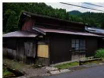
図 16 平屋建鉄板葺の付属屋
