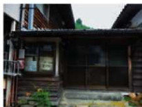
図 28 芦津部落事務所繋ぎ部
