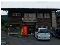
図 26 芦津部落事務所事務所棟
