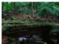
図14 13 昭和10年製作の橋
