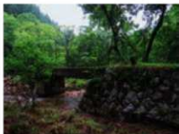
図19 18 林道分かれコンクリ橋
