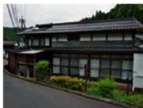
図12 2階建瓦葺の主屋
