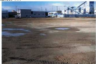
埋戻し後の状況（東から）
