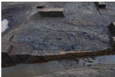
SD30 確認状況（東から）
