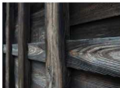
壁板部分拡大 (同右)
