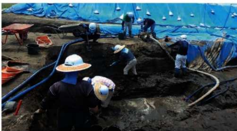
SD 1 作業風景
