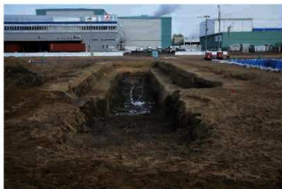
3トレンチ 完掘状況
