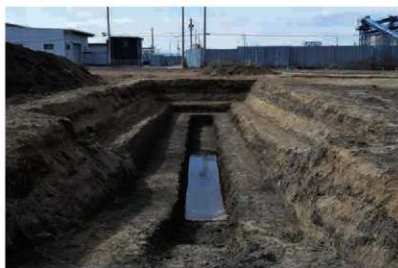
5トレンチ 完堀状況（東から）
