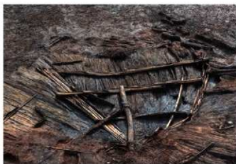
2 11-1区1面1号建物1号屋根近撮(北から)
