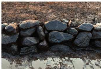
4 11-1区1面60号溝石積み状態(東から)
