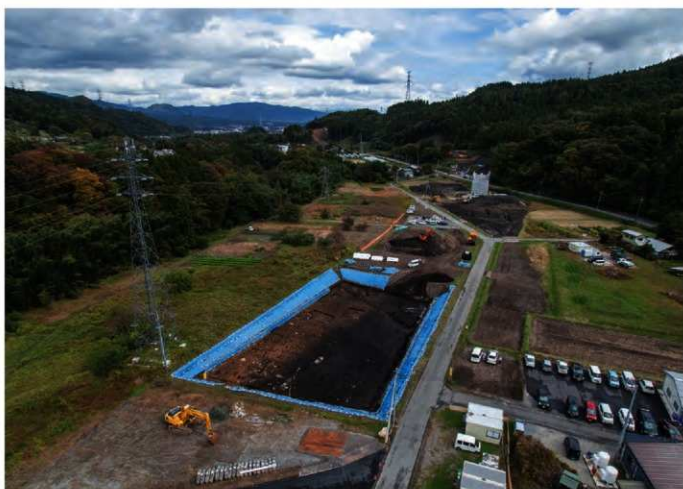
2 11区3面遠景(西から)
