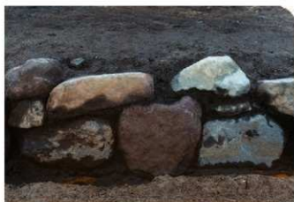
4 15区1面58号溝石積み近撮(北から)
