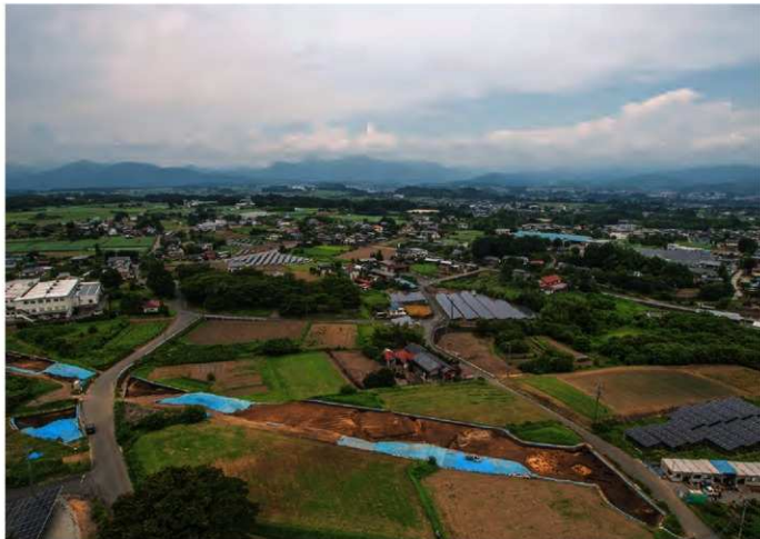
1 中道跡1区全景(東より)
