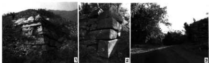
図9 高句麗古墳と日本古代山城の算木積 1. 業安西大塚古墳南東隅角部 2. 讃岐城山城跡城門北側石積み(西より) 3. 讃岐城山城跡城門(西より)
