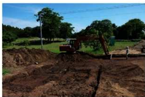
2. 重機による表土除去（北から） [Z10442]
