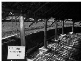
屋根ジャッキアップ、茅葺下部撤去。土間・周境撤削、鉄筋設置、ゲヤ柱交換・防風処理など (1号棟)
