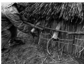
茅葺の復旧 (1号棟)
