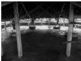
土間・周境下コンクリートのベタ基礎新設 (1号棟)
