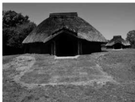
芝生修繕作業後（3号棟 令和5年4月）
