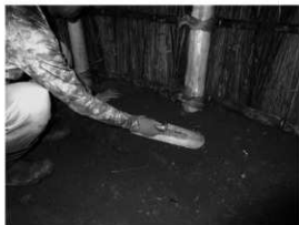
土間・周境の復旧 (1号棟)
