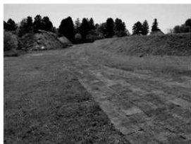
芝生修繕作業後（令和5年4月）
