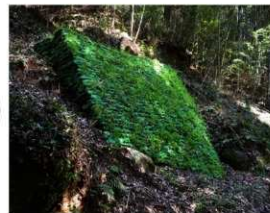
植生土壌積み施工箇所 R6.3.14撮影
