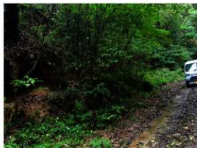
池ノ尾門跡地区（F地点）工事着手前
