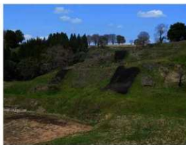
長繊維混入補強吹付工法施工箇所 R6.3.14撮影
