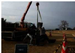
設置作業風景
