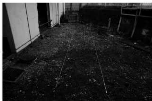
試掘坑設定状況 (東から)
