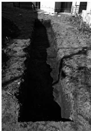
試掘坑 2 全景 (南から)
