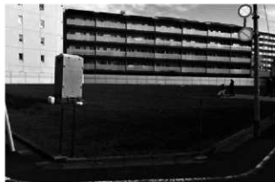
敷地全景 (南西から)
