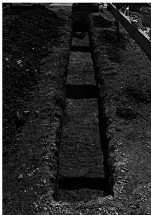
試掘坑2全景（北から）
