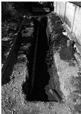
試掘坑全景 (南東から)
