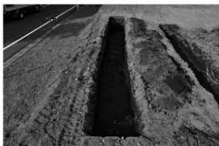
試掘坑 1 全景 (南から)
