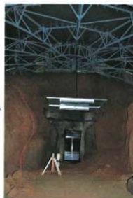
永安寺西古墳保護施設内
