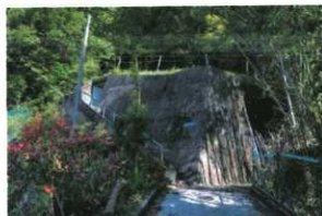
大坊古墳保護施設（南から）
