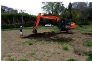
2. 重機による表土除去（南東から） [Z9641]
