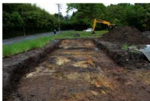
1. 重機による表土除去(南から) Z9157
