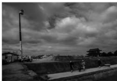
図32 高所作業車による撮影風景 (第522次)
