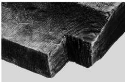
図115 横板F1下面の欠込
