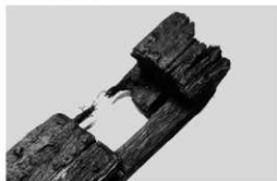
図111 土居柝（南側）の相欠仕口・ホゾ穴
