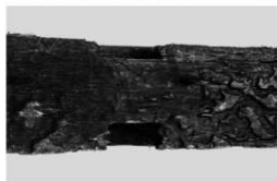
図110 土居柝（西側）下面の欠込
