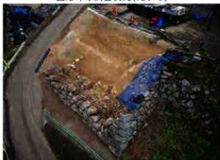
15面上段・16面石垣解体状況(北東から)
