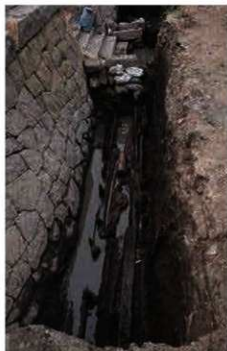
石垣護岸及び板材検出状況(南から)
