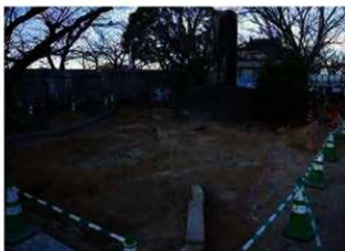
園路部分調査状況(南東から)
