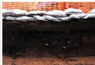
SA1 間仕切り1 西壁土層断面（東から）
