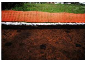
SB4 検出状況 (西から)
