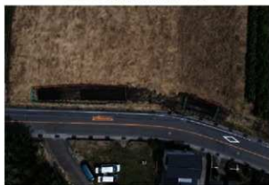
A 区西側側道の調査状況 (俯瞰)
