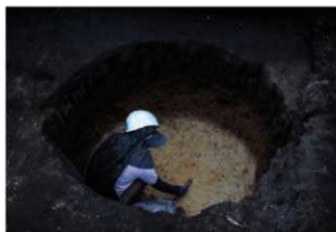
SC3 掘削状況（東から）
