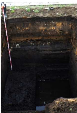
A 区東側側道のトレンチ掘削状況 (北から)
