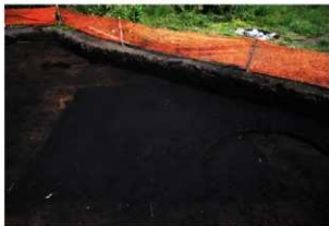
SA4 検出状況 (西から)
