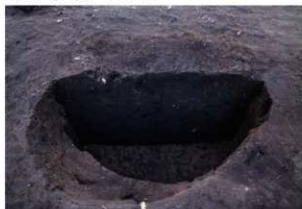
SC4 掘削状況（東から）
