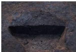
SC1 掘削状況（北東から）
