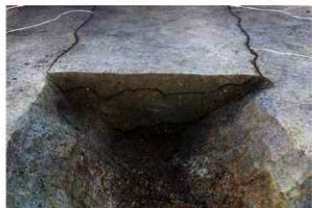
SD10 断面(北東から)
