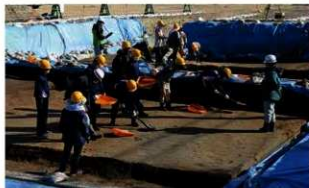
河川跡の掘り下げ作業
