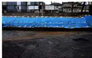
2区 西側 南壁(北から)
