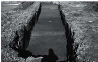
2. 2T 遺構検出状況 (南から)
