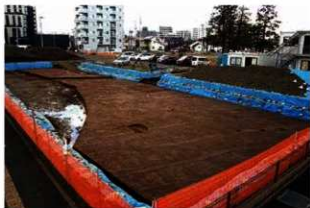
1区IV層上面 小溝状遺構群確認状況(南東から)
