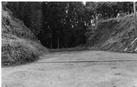
(2) 表土剥ぎ終了状況 (北より)
