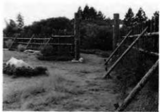
(7) 主郭部整備状況(門・柵跡)
