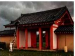
落ちかけた瓦の補修作業
