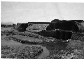
写真30 六枚戸陸側(北西から)
