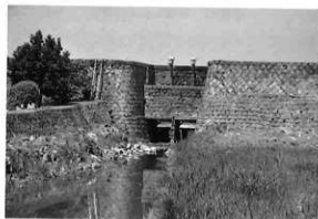
写真35 二枚戸海側①(東から)
