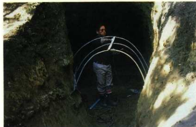
図版65 12号横穴 ステンレス支柱取り付け
