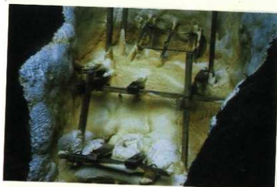
図版67 12号横穴 発泡ウレタン 吹き付け1回目終了
