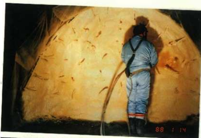
図版61 9号横穴奥壁 ウレタン吹き付け
