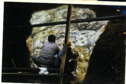
図版69 12号横穴 ウレタン被覆 FRP貼り付け
