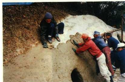
図版59 2～5号横穴 ステンレス金網取り付け後 サイト製土貼り付け
