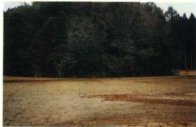
図版121 御諏訪池奥広場修景 完成
