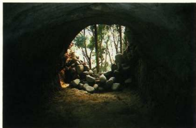
図版47 52号横穴隧道部
