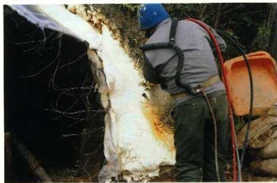
図版76 13号横穴 発泡ウレタン吹き付け
