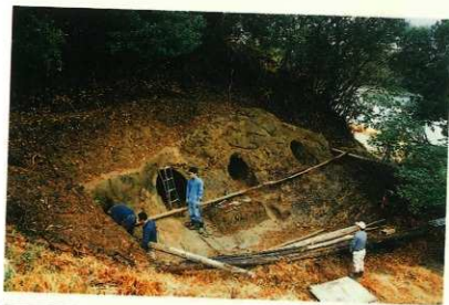
図版55 2～5号横穴 足場取り付け
