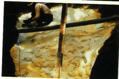
図版68 12号横穴 発泡ウレタン吹き付け完了
