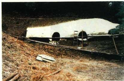
図版58 2～5号横穴 発泡ウレタン吹き付け
