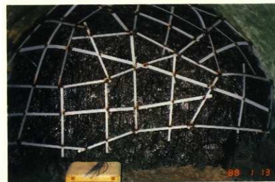
図版60 9号横穴奥壁 サンコール含浸後の ステンレス骨組み
