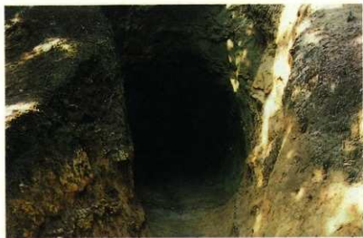
図版64 12号横穴 保存工事着工前
