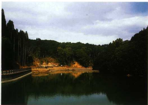
ゾーンⅢ（稲荷池西岸）整備状況
