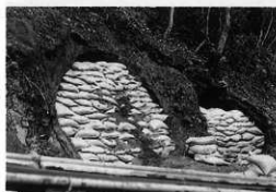
保存修理の各種工法
