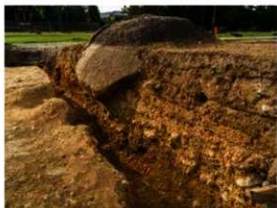
第3図 礎石位置の基壇土（南東から）
