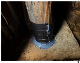
第24図 9号住居の柱木材の修繕
