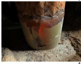
第24図 9号住居の柱木材の修繕
