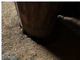
第1図 地震による被害（9号住居）
