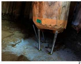
第23図 柱付近の土留柱と土のイメージ
