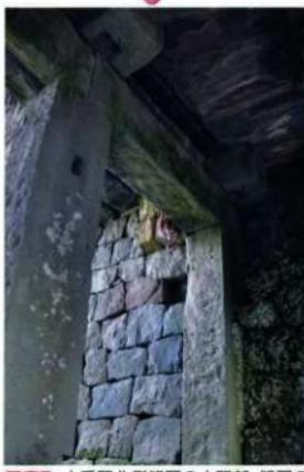
写真7 十番開北側樋門の水門部。樋門の外側は後世の改修部分であるが、水門部などの構造は江戸時代の構造がそのまま残る。
