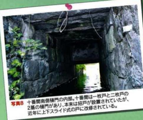
写真8 十番開南側樋門の内部。十番開は一枚戸と二枚戸の2基の樋門があり、本来は招戸が設置されていたが、近年に上下スライド式の戸に改修されている。
