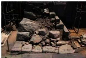
一ノ門 (東側) 解体終了 西から
