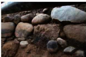
SD010(石組暗渠) 北東から
