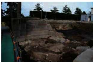
3240W(北側石垣台西面)・SX026(東側頬当石垣階段)・ 3241(東側頬当石垣) 南西から
