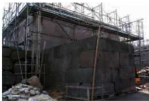
一ノ門 (東側) 積み直し完了 北西から
