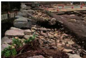
解体前 裏込め表土堆積状況 西から
