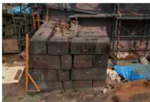
3241 (一ノ門東側) 解体調査前 西から
