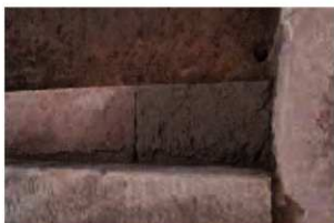
SX028(ニラミ槽台南側階段)
