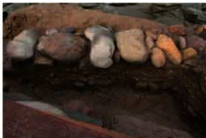
3220S(土塀裏盛土留石垣) 南から
