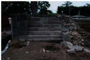
SX026(東側頬当石垣階段) 南から
