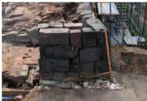
3231 (一ノ門西側) 解体調査前 東から
