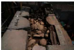
一ノ門 (東側) 裏込め 西から
