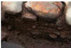
3220S(土塀裏盛土留石垣) 南から
