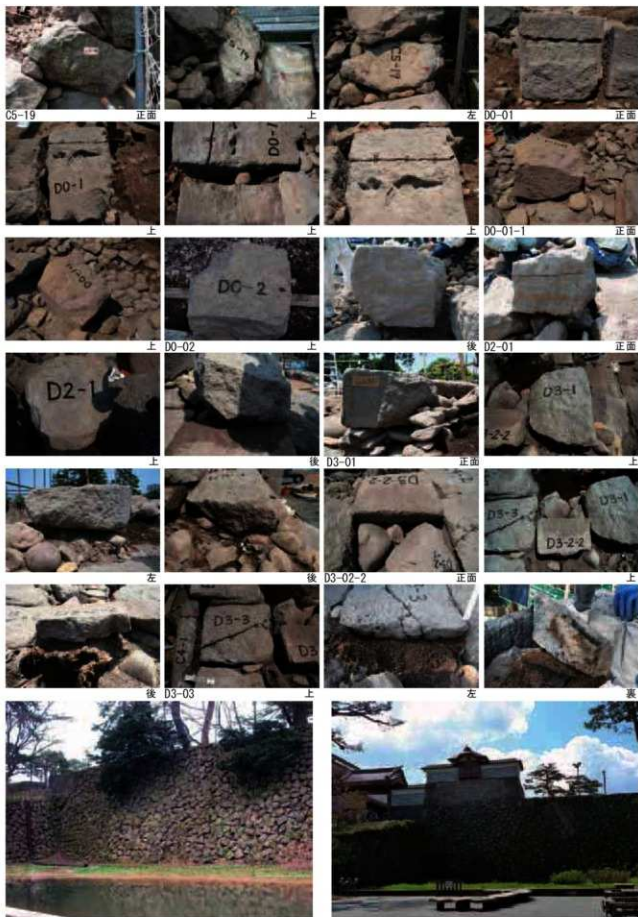
ニラミ槽台北面石垣解体前
