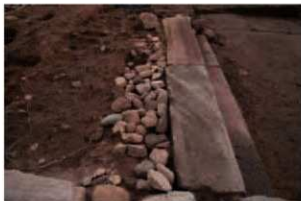
SX028(ニラミ槽台南側階段) 北から
