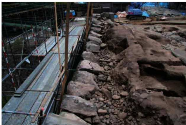
3500N（ニラミ槽台） 解体後 西から
