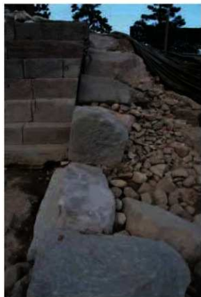
3240W(北側石垣台西面) 南から
