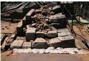
一ノ門 (西側) 解体終了 東から
