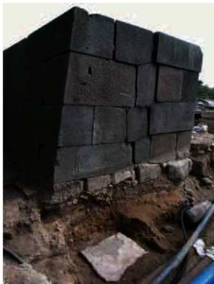
3241W(東側頬当石垣西面) 北西から
