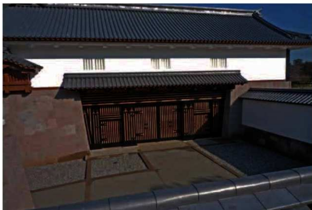
復元された櫓形内部及び二ノ門（西から）
