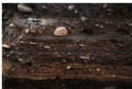
異なる質の土を積み重ねる。層ごとに硬く叩き締められる。
