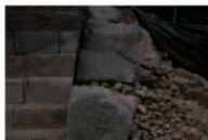
③ 割石材の側面及び上面に合端加工を行い切石材を積む
