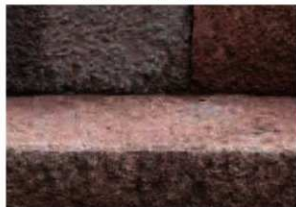
雁木右端部 (面取り) 加工状況 西から ニラミ櫓台南側階段
