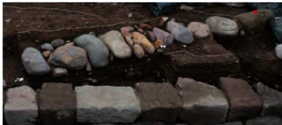
① 3220S全景（三ノ丸側） 石材の長軸を控えて並べる。★印石のみ横置き
