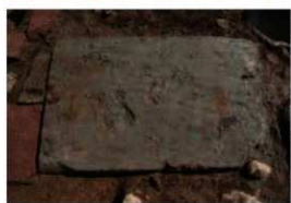
P005 東西 66 cm 南北 92 cm 上面標高 42.72m 柱金具痕跡 東西 45cm 南北 66cm
