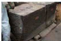
③ A7段とA8段の西面のズレ
