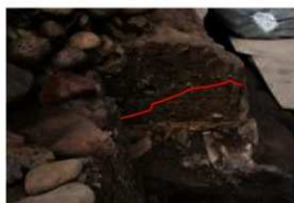
④ 3240W (北側石垣台西面)の背後の掘方石垣掘方は盛土層を掘込む。掘方内は栗石と土が歯状に堆積
