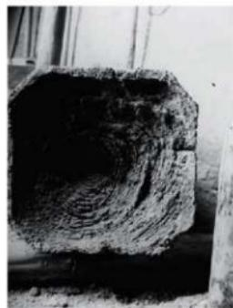
1.240 多門 解体中 柱根元の朽腐詳細
