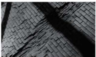
1.31 表門 解体中 土居葺 腐朽状況
