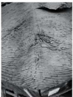
1.82 檜 解体中 下層 土居葺 破損
