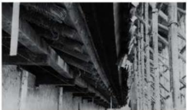
1.169 多門 解体中 北側軒裏 壊落した処 東より西を見る
