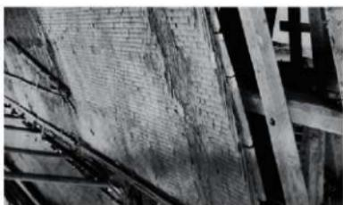
1.137 長屋 解体中 南側 屋根土居葺 腐蝕
