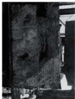
1.239 多門 解体中 柱根元の朽腐詳細
