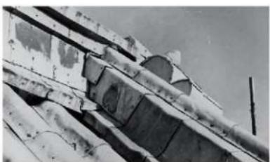
1.144 多門 修理前 西側 大棟及下り棟 取り付け破損
